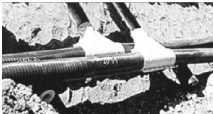
Рис. 47. Перетин тепломереж
